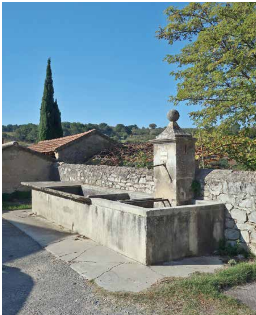
La fontaine-lavoir des Hautes Granges
