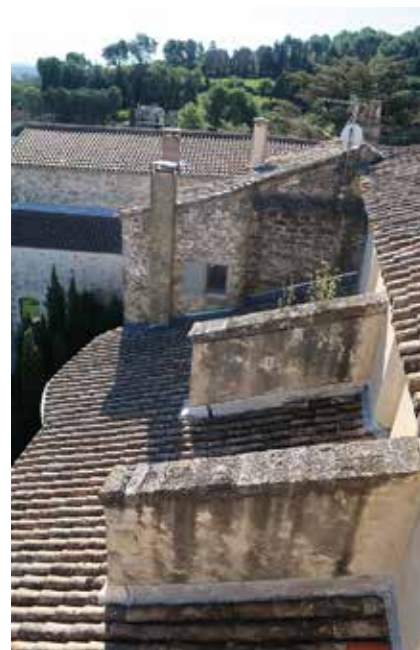
Toiture de l'église
