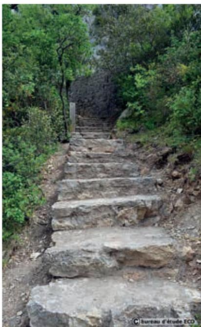
**Maçonneries béton de site, enduites et à pierres vues** - Valorisation du site de l'ancienne usine d'ocres Mathieu - Roussillon (84)
