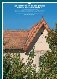
16 les toitures en tuiles plates
