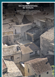
14 les modifications de toiture
