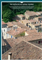
05 les toitures en tuiles rondes
