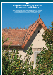
16 les toitures en tuiles plates dites marseillaises
