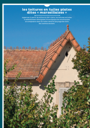
16 les toitures en tuiles plates dites marseillaises
