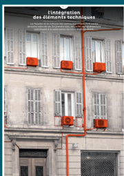
10 l'intégration des éléments techniques
