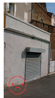
Porte au nu de la façade et coffre plaqué à l'extérieur
