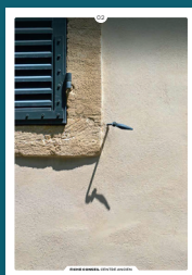
02 les finitions d'enduit
