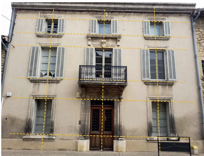
Composition d'une façade courante : axialité et hiérarchisation des percements, protection du soleil et de la pluie.
