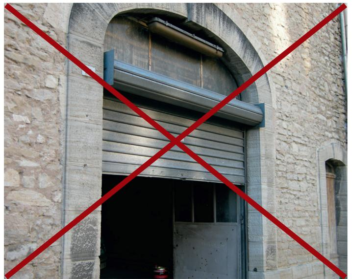
Fermeture d'un porche avec maçonnerie en linteau et mise en place d'un volet roulant métallique avec coffre positionné à l'extérieur
