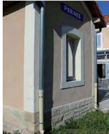
6. Plinthe de pierre-ocre jaune et chaîne verticale d'angle formant un pilastre en pierre de calcaire blanc
