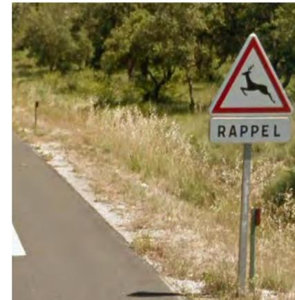
Piquets réflecteurs permanents installés dans le Gard (RD 999), complétés par des panneaux A15b avec rappels.
