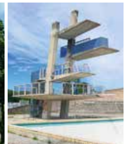
Le plongeur avant travaux
