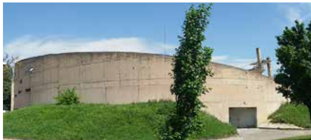
Le mur anti-mistral avant travaux
