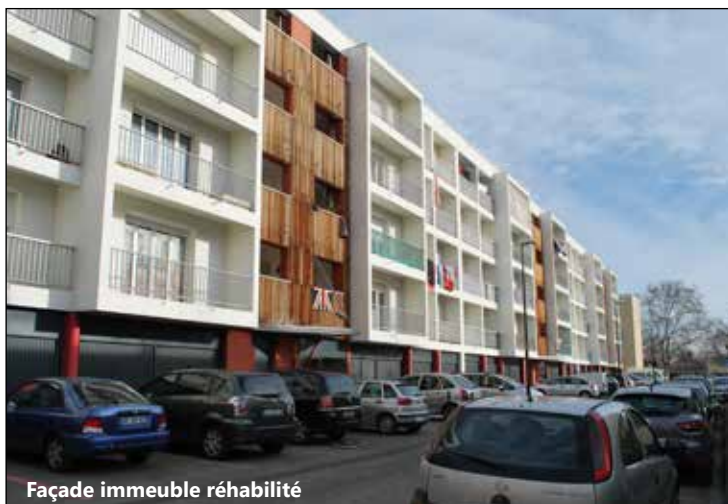
Façade villa double réhabilitée
