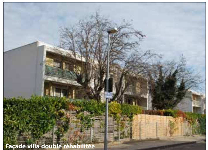
Façade villa double réhabilitée
