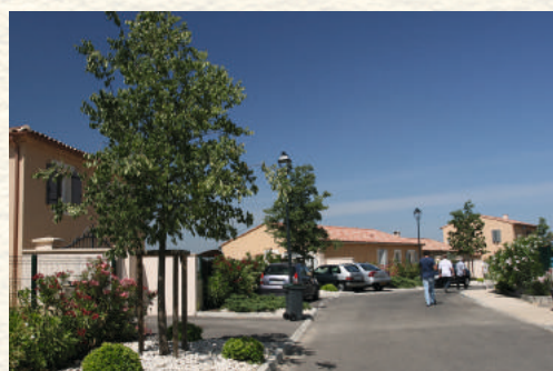
Desserte d'un lotissement communal à Saint-Pierre-de-Vassols
