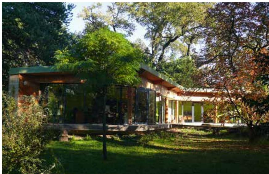
débord de toiture et la généreuse végétation arborée ; toit à pente unique incliné vers le nord pour « lever » le mistral ; plancher de bois
