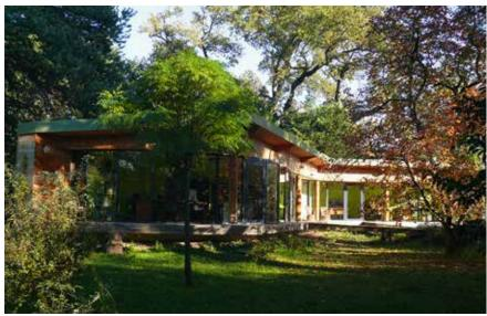
débord de toiture et la généreuse végétation arborée ; toit à pente unique incliné vers le nord pour « lever » le mistral ; plancher de bois surélevé par rapport au sol et rafraîchi par la circulation d'eau d'irrigation commandée par des martelières depuis un canal.
