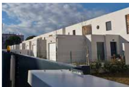
Résidence Rameau à Avignon (Jean-Paul Cassulo, architecte)
